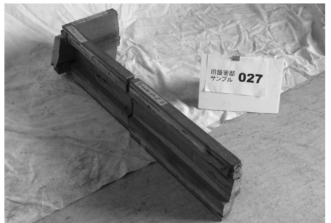
写真10 北側出入口枠（サンプリングされた部材）
