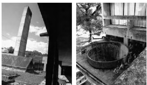
⑥外部螺旋階段（地下厨房搬入口）
