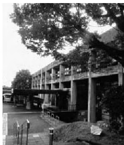
①南庁舎東側を見る
