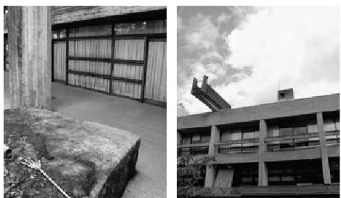
⑦西側屋根から大きく突出する消防ホース掛け
